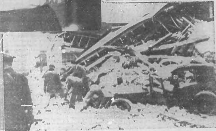
El terremoto de Hollywood. Varios obreros separando los escombros de un edificio que cayeron sobre un automóvil, dentro del cual murieron dos hombres. (Int. News Photo).
